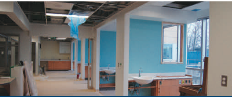
Unité médicale de jour / Oncologie (en construction) Medical Day Unit / Oncology (in construction)
